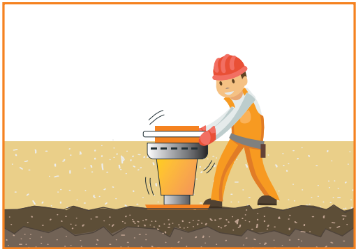
Bước 2: Nền móng: Sử dụng cát hoặc loại đất tốt (đất không có cát sỏi) cho nền móng. Đầm nền bằng máy đầm rung hoặc vỗ đập đất để làm chặt nền.
