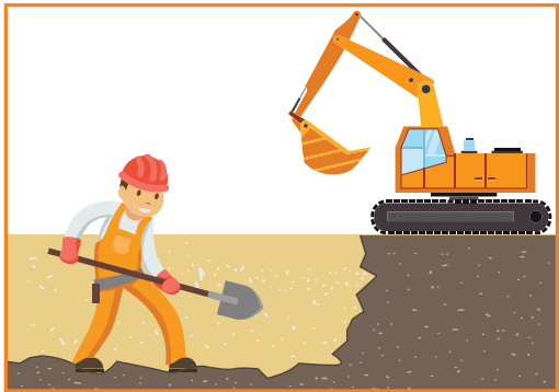
Bước 1: Đào đất: Đào đất để lắp hộp kiểm soát kỹ thuật. Chú ý dàn phẳng lớp đáy, không đào quá sâu và không để đất gồ ghề.
